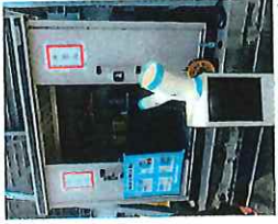
岸壁に設置されている休憩所とスポットクレーナー
