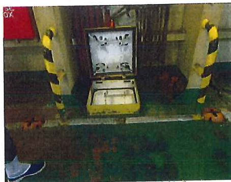
ハッチの開口部付近
