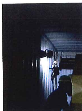
コンテナ作業用の照明
