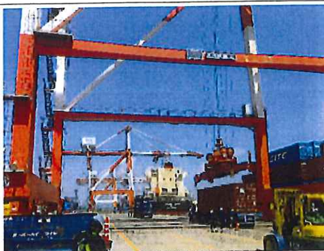
巡視場所全景
