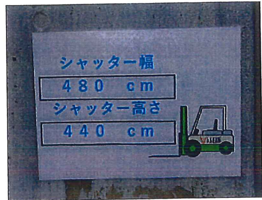
シャッターの幅・高さ表示
