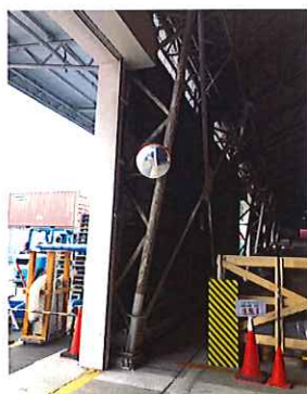
(カーブミラー設置)
