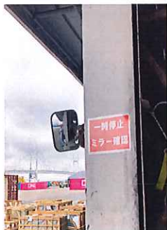
(カーブミラー設置)
